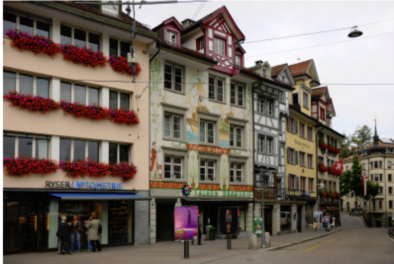
... UND DER VOR WENIGEN JAHREN WIEDER HERGESTELLTE ALTE ZUSTAND DER FASSADE ALS NUNMEHR NEUER (FALKEN-DROGERIE)
